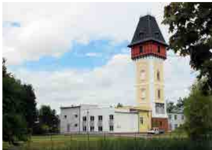
Vodárenská věž – celkový pohled.
