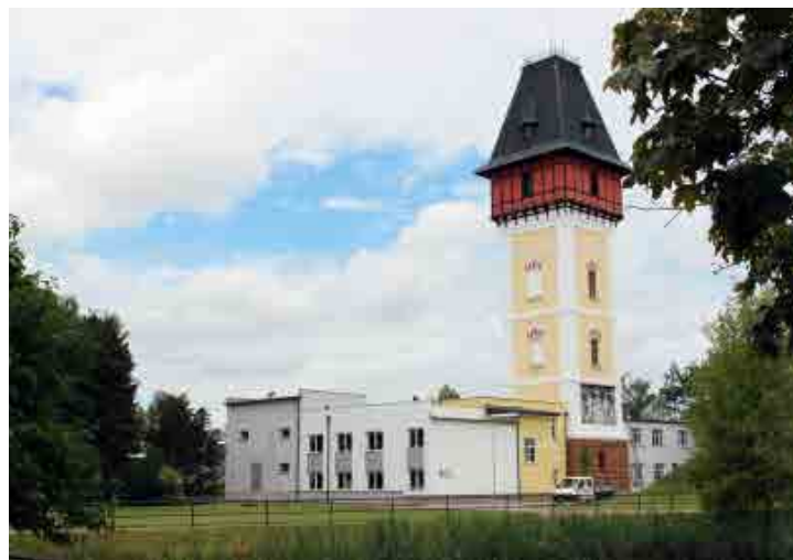
Vodárenská věž – celkový pohled.
