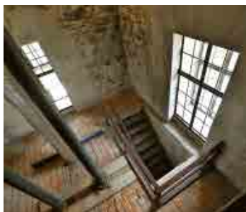
Interiér Vodárenské věže.
