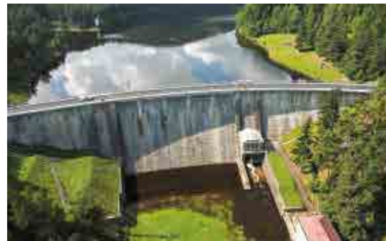
Poslední zděná hráz v Československu – Husinecká přehrada. Dokončena byla roku 1939.
