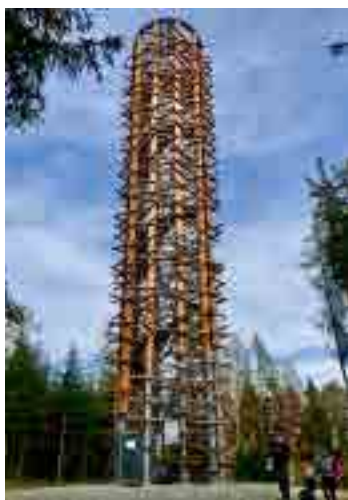
Rozhledna na Hradištském vrchu je vzdálena 3,5 km od Kaplice.
