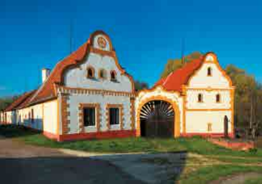
Krásný příklad jihočeského lidového stavitelství – stavek v Bavorovicích.
