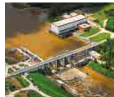
Přehrada Hněvkovice, vpravo odběrný objekt vody pro elektrárnu Temelín.
